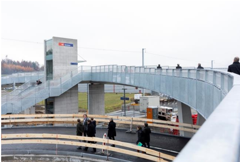
Abbildung 3: Eröffnung der Velo- und Fussgänger-Passerelle beim Bahnhof Givisiez (© Kanton Freiburg)
