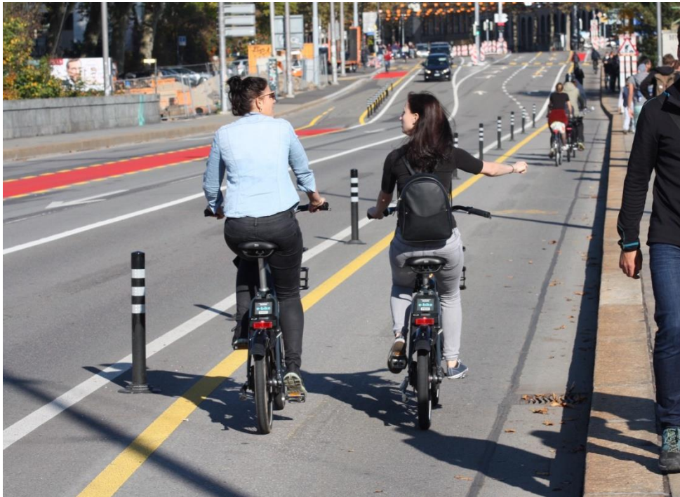
Abbildung 2: Die Lorrainebrücke mit rund 10`000 Velofahrenden an Spitzentagen. Verbreiterung des Radstreifens von 1.50 auf 3.00 m, womit das Nebeneinanderfahren und Überholen innerhalb des Radstreifens ermöglicht wird. (© Stadt Bern)
